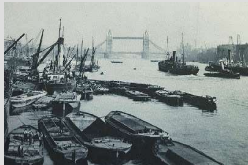
Anciennes grues de levage
